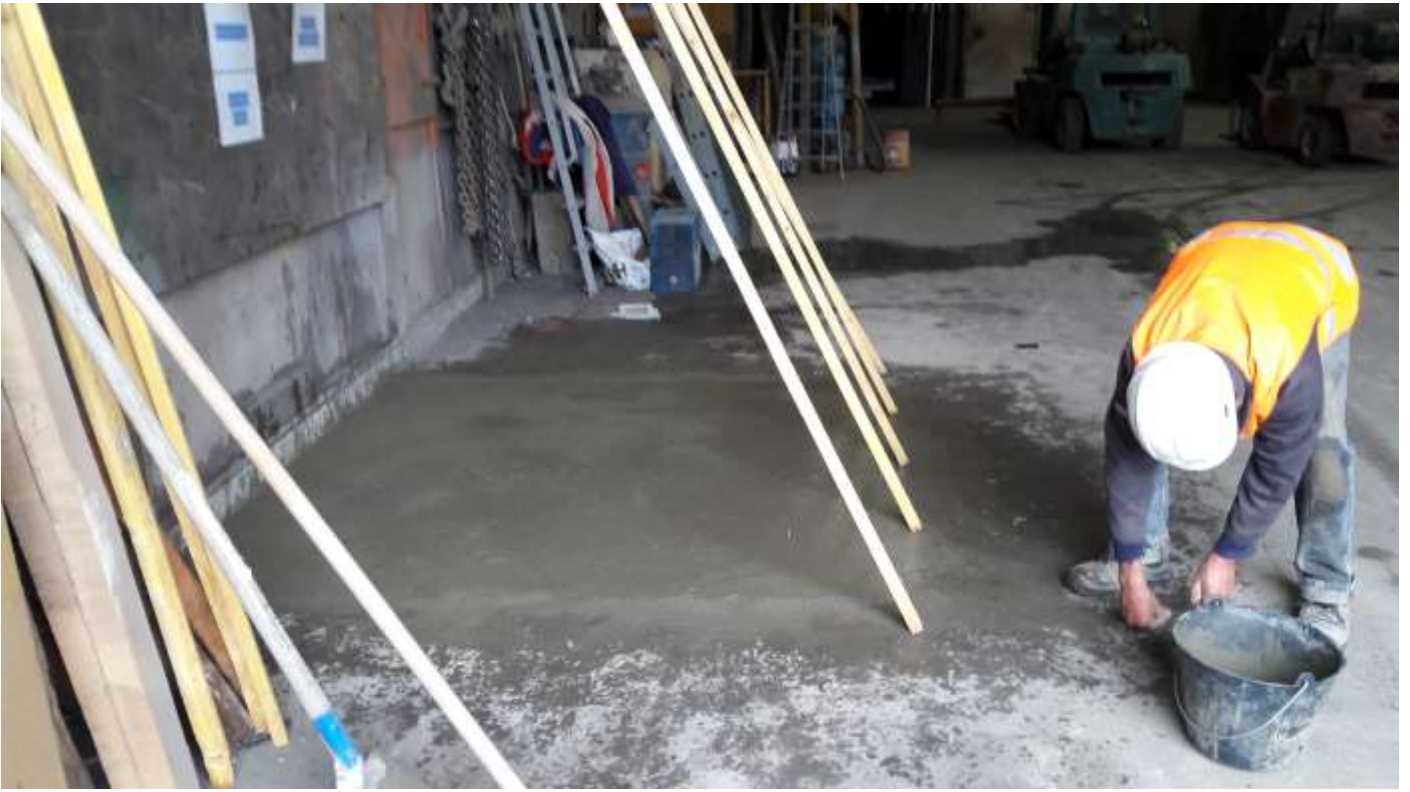
Photographie des réfections de la zone 3
