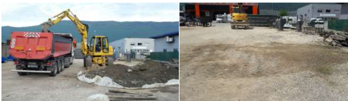
Figure 4 : Photo des évacuations de terres du site de Voglans
