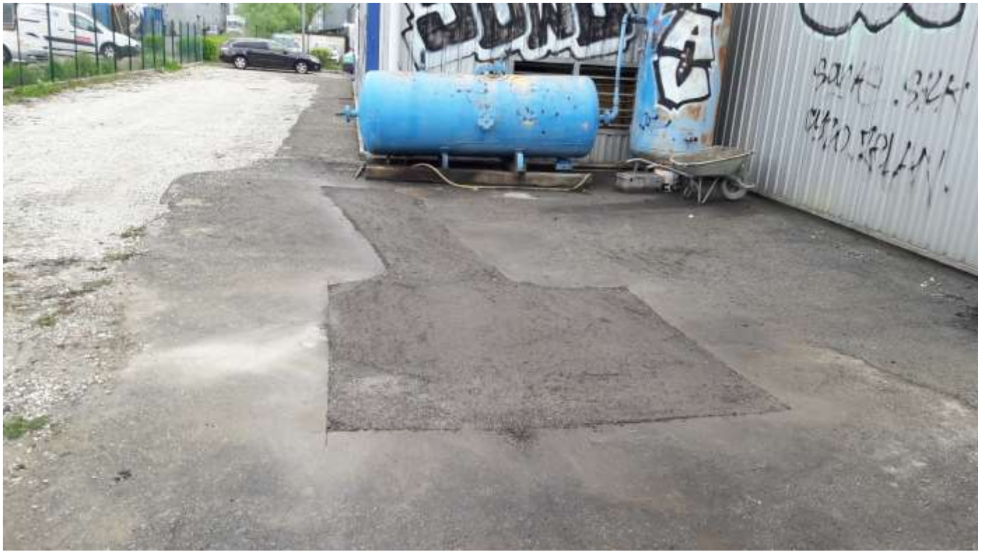
Photographie des réfections de la zone 9
