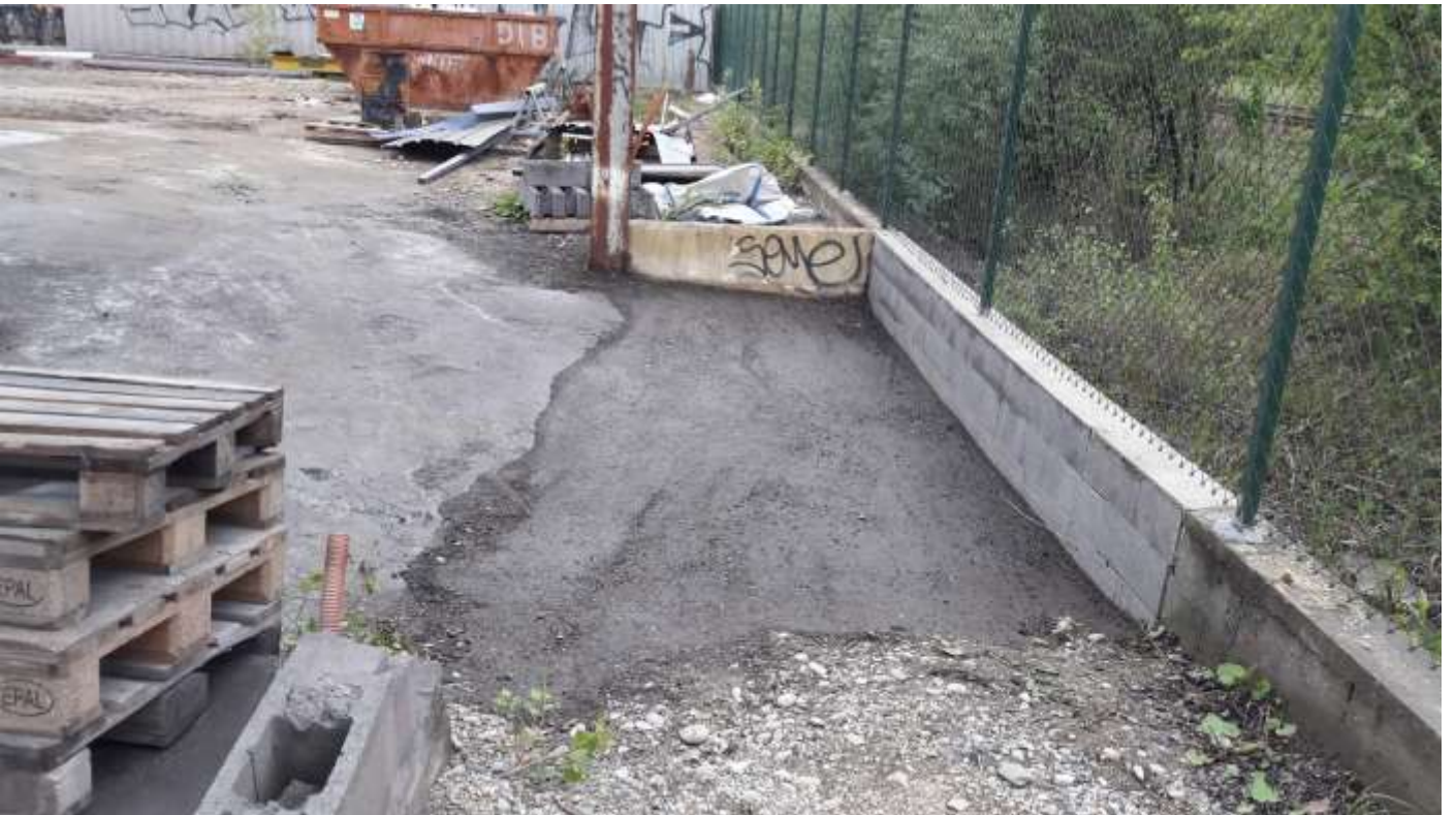
Photographie des réfections de la zone 8
