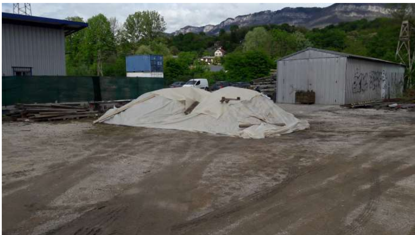
Photographie des stockages de terres polluées
