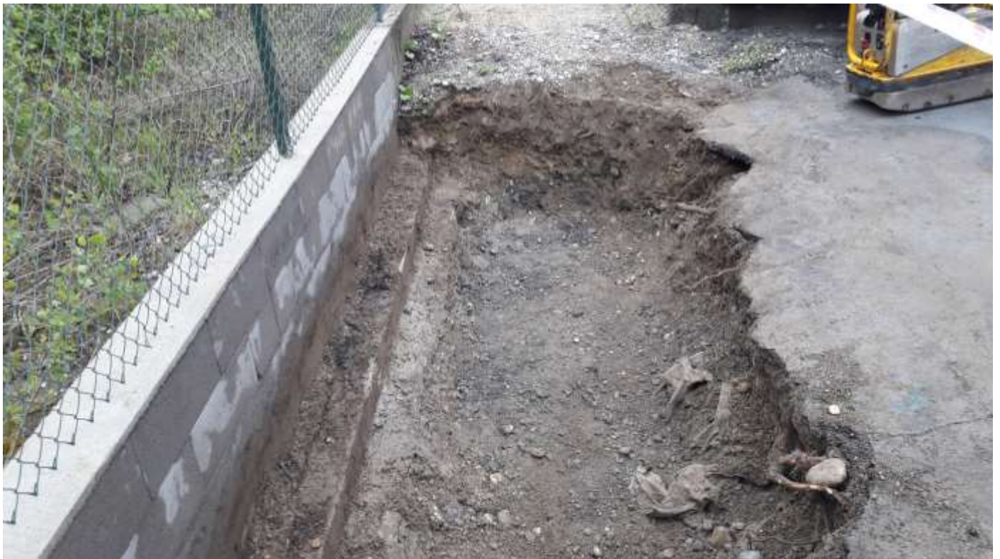
Photographie des terrassements de la zone S8
