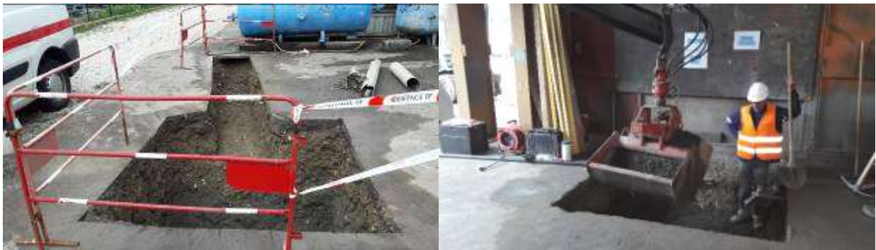
Figure 1 : Photo des opérations du chantier de Voglans
