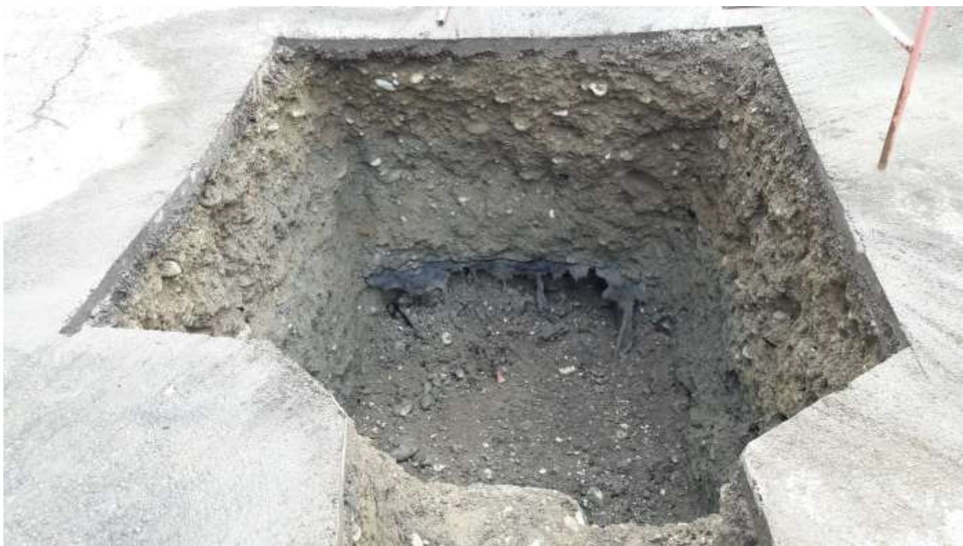
Photographie des terrassements de la zone S9
