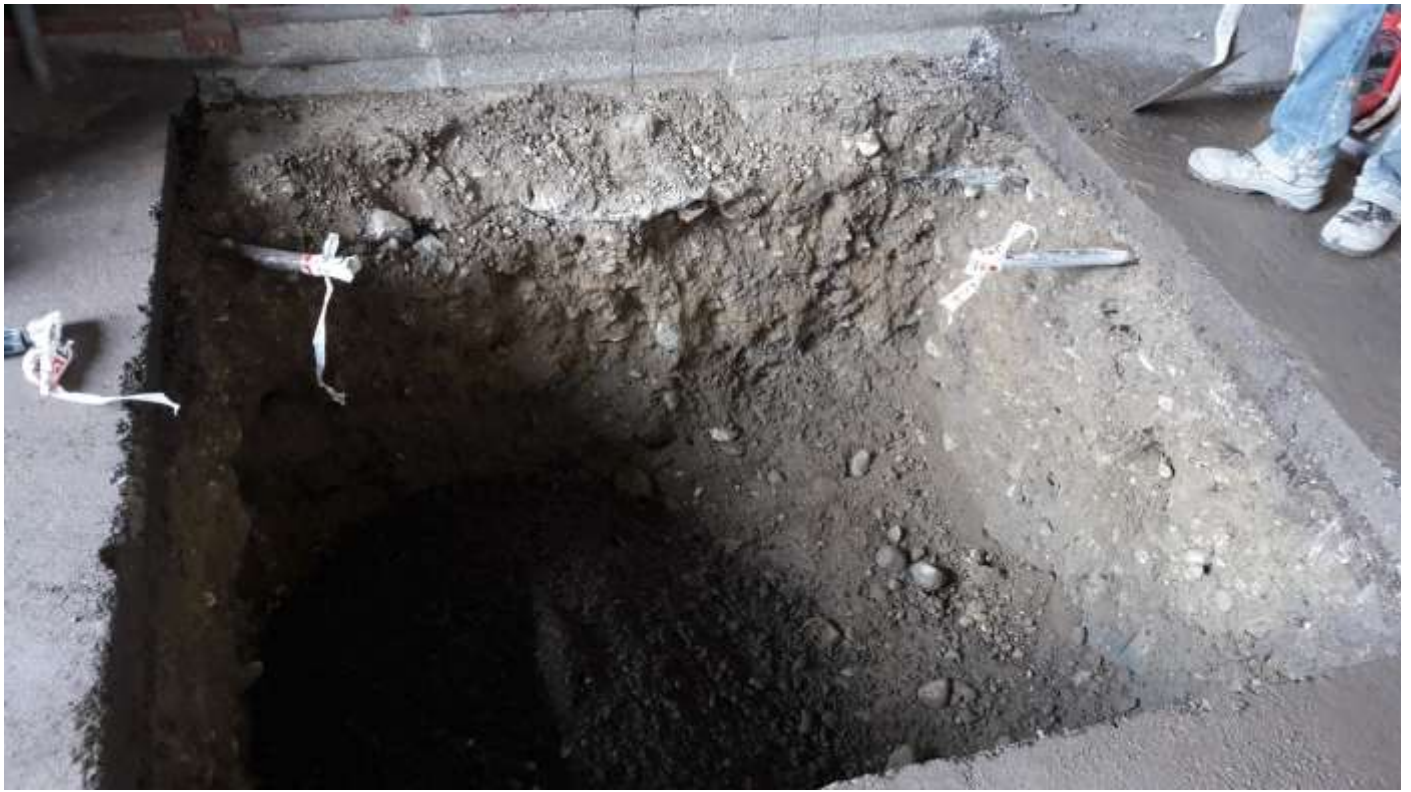
Photographie des terrassements de la zone S3
