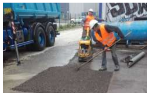
Figure 3 : Photo du remblayage du site
